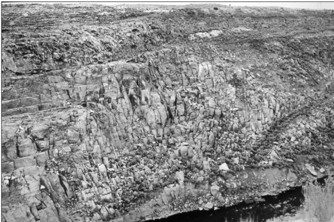
Figura 2.9. Aspectul rocii de fundare a barajului Teton.
